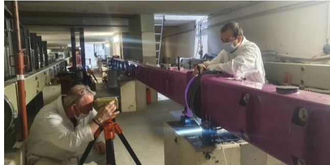
Remplacement et alignement des nouveaux guides de neutron
