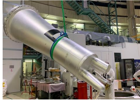
Assemblage du nouveau doigt de gant H1H2
